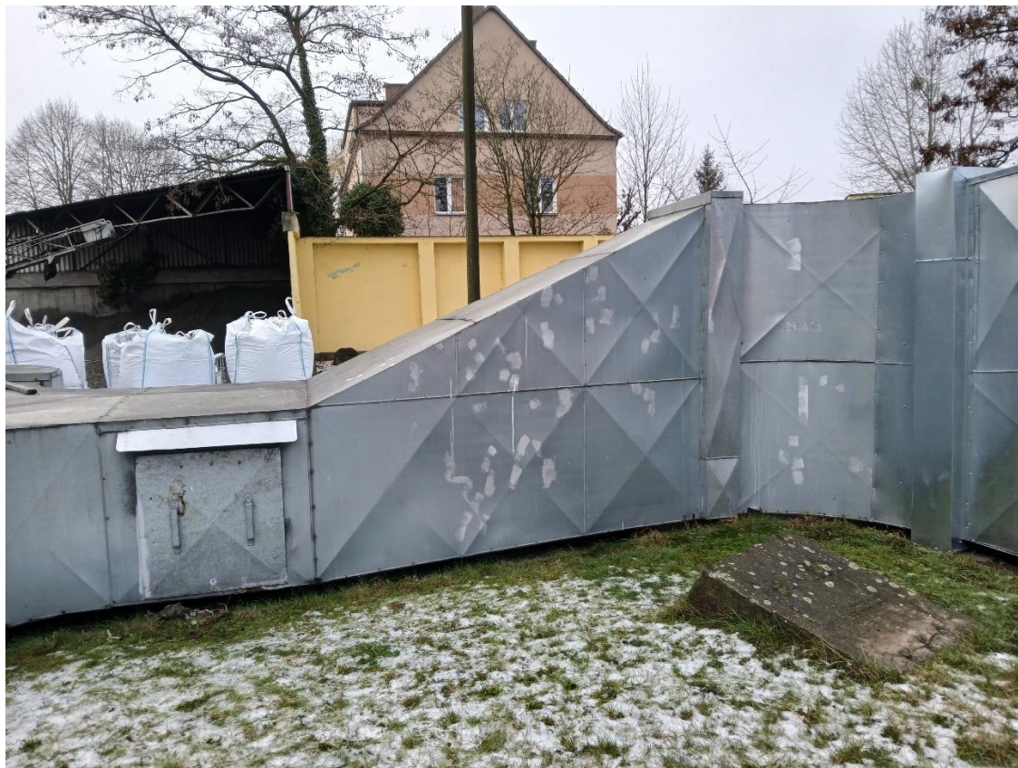
Fot. 3. Kanały przeznaczone do wymiany – widok (3) na kanał zbiorczy
