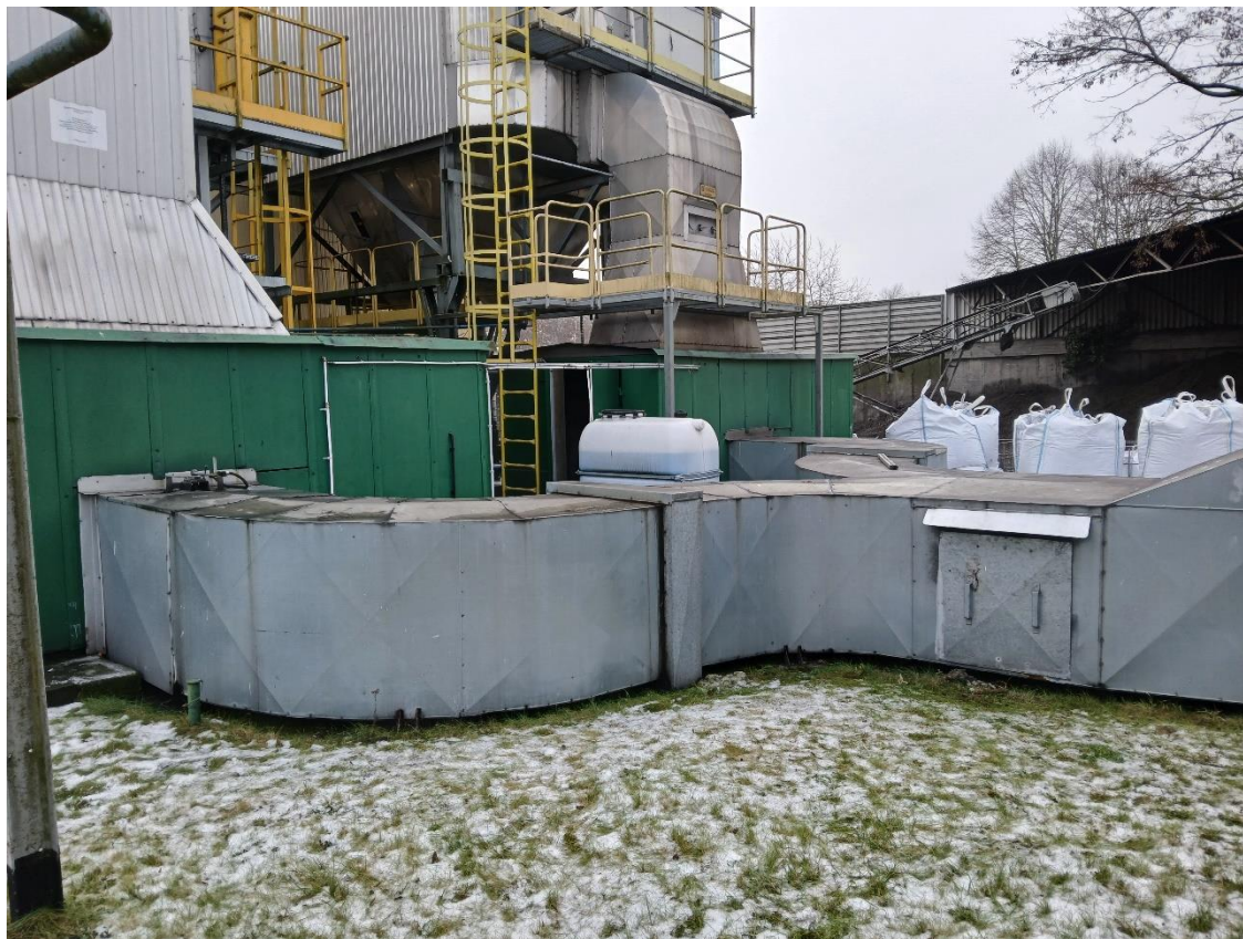
Fot. 3. Kanały przeznaczone do wymiany – widok (3) na kanał zbiorczy
